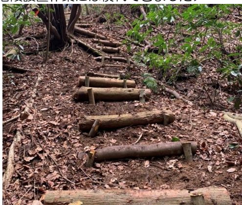
<階段設置作業には慣れてきました>
