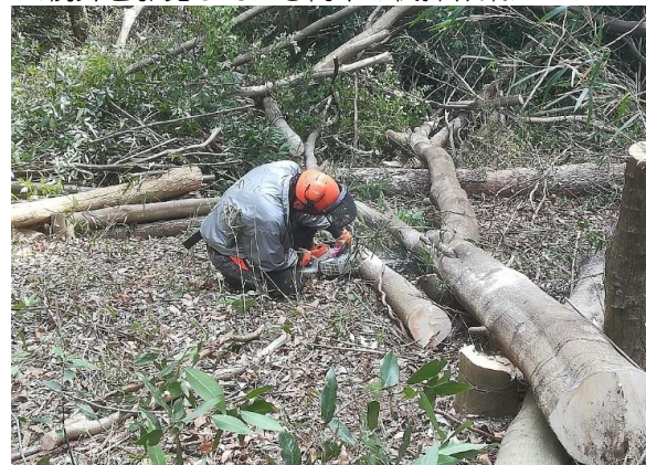
＜視界を邪魔している樹木の伐採作業＞
