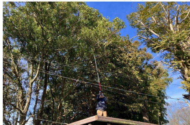
<午前中は電線にかかる枝を取り除きました>
