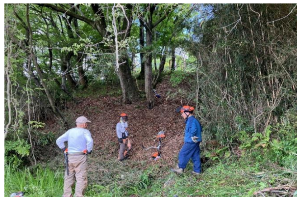
<作業終了。あとは階段整備です。>
