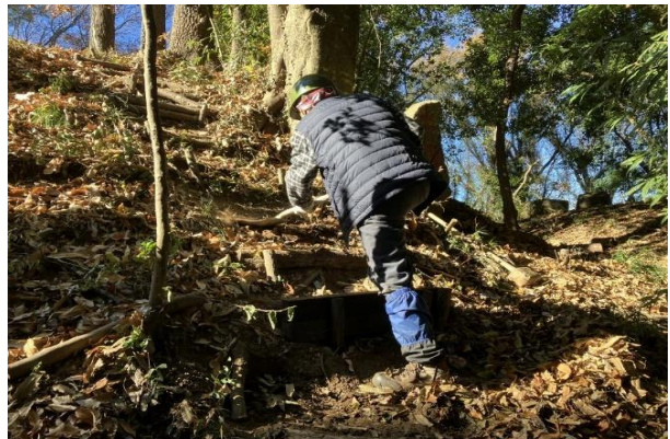
＜壊れた階段を修理しています＞
