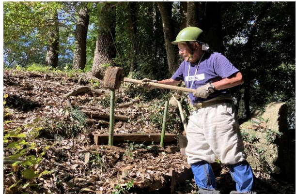
＜壊れた階段を竹を使って修理中＞
